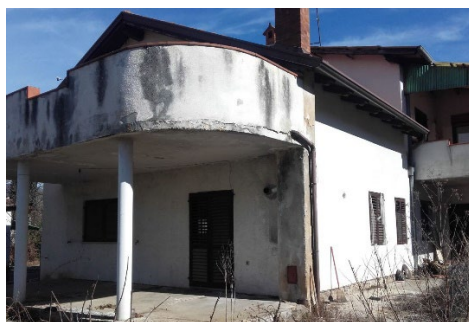
Slika 1: Stanje pred rekonstrukcijo
