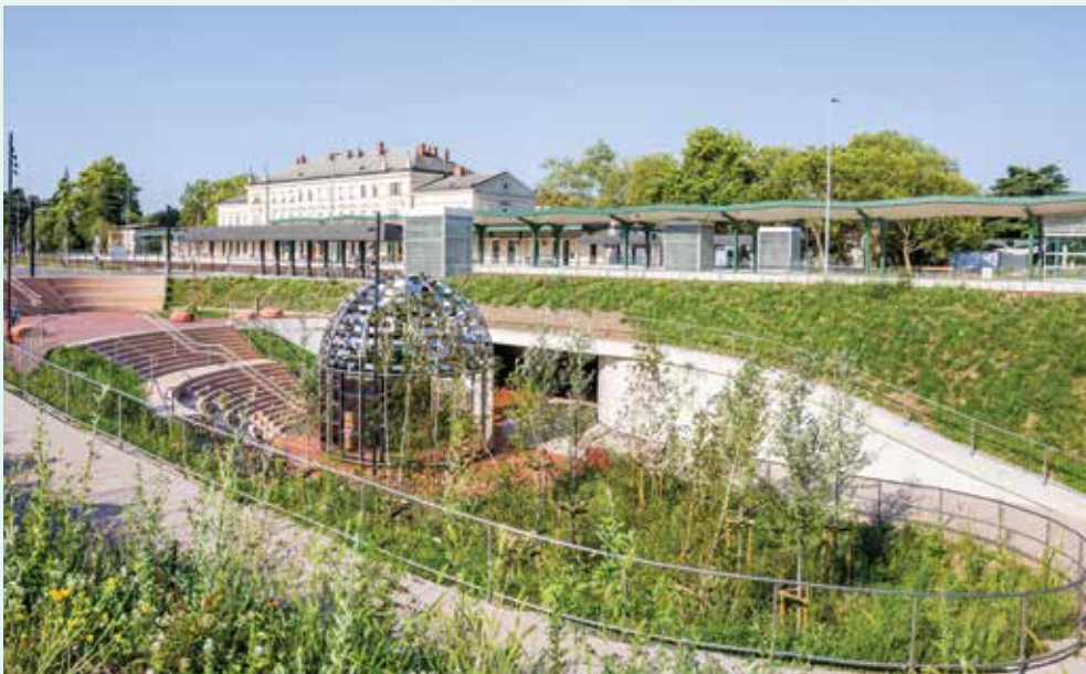
Prenovo novogoriške železniške postaje
